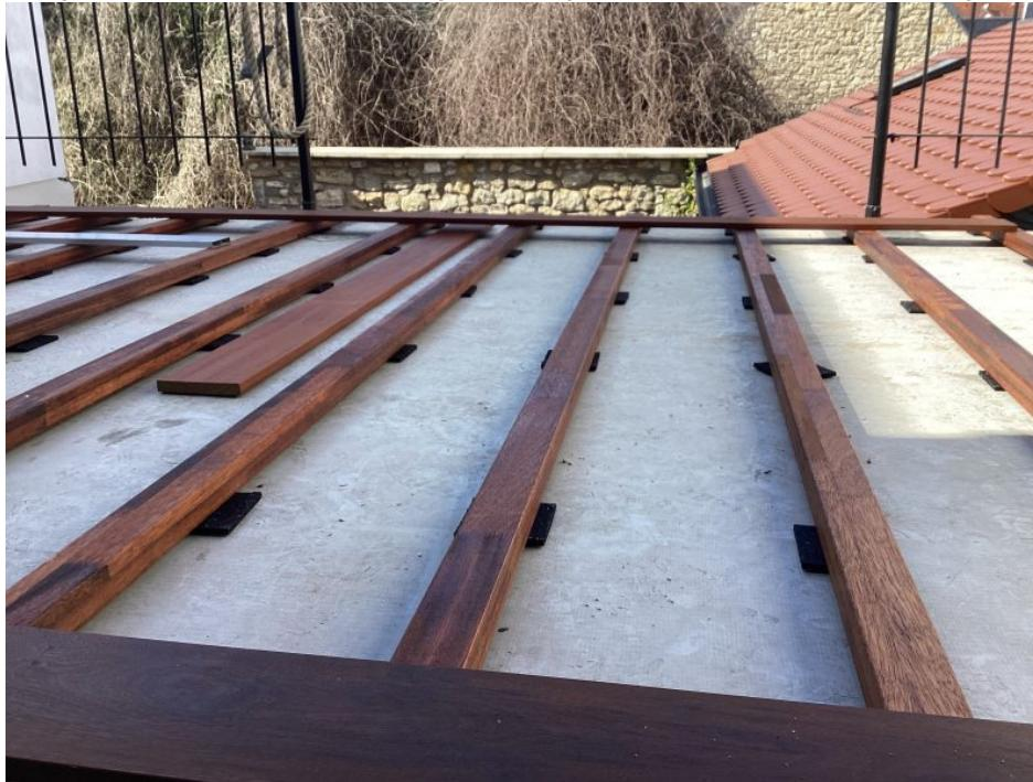
Bei der Verlegung schützt eine Unterkonstruktion die Dielen vor Feuchtigkeit und sorgt für eine Hinterlüftung der Auflageflächen (Bild: Heco).
