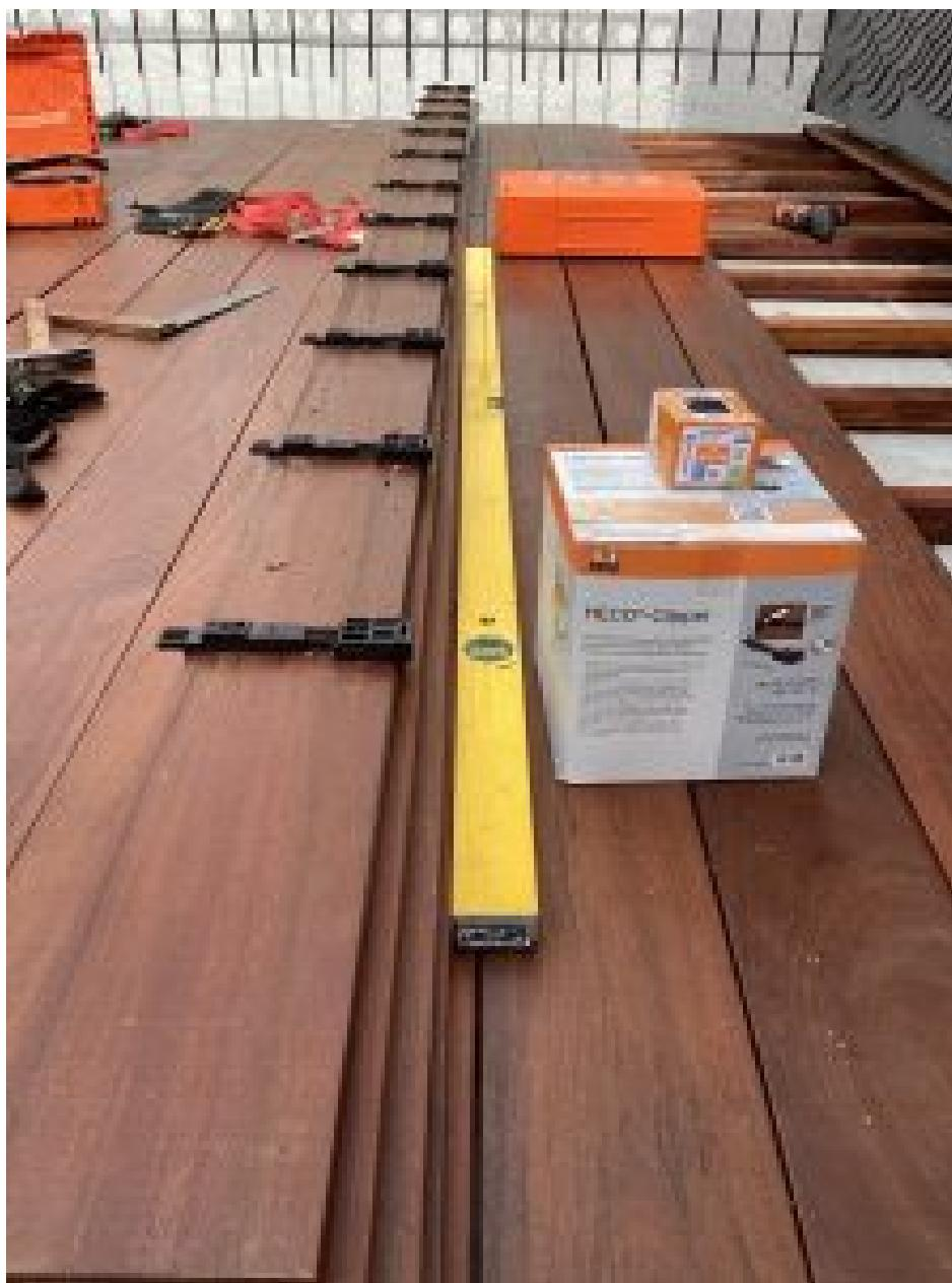
Die »Clipper« werden auf der Rückseite der Dielen befestigt, bevor diese umgedreht und auf der Unterkonstruktion montiert werden (Bild: Heco).
