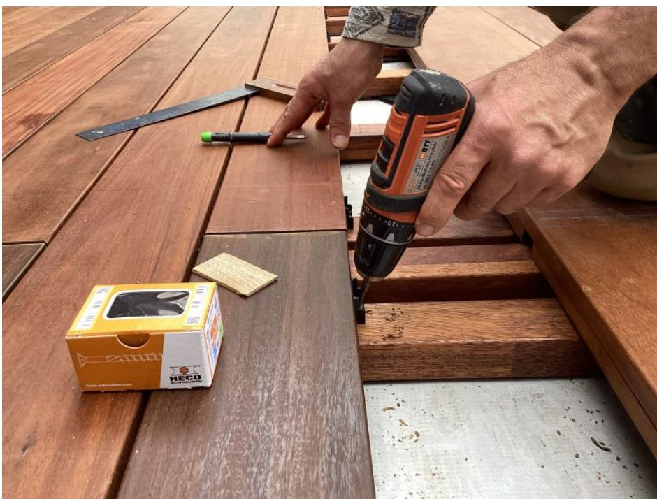
Nachdem die Diele umgedreht wurde, wird sie in den beiden noch sichtbaren Bohrlöchern auf der Unterkonstruktion montiert (Bild: Heco).
