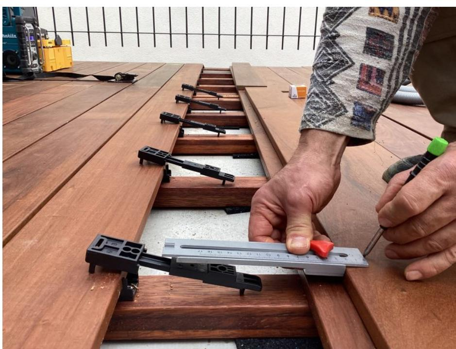
Die Montageposition der Befestigungen aus Kunststoff wird auf den Dielen angezeichnet (Bild: Heco).
