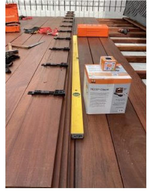
Die »Clipper« werden auf der Rückseite der Dielen befestigt, bevor diese umgedreht und auf der Unterkonstruktion montiert werden (Bild: Heco).
