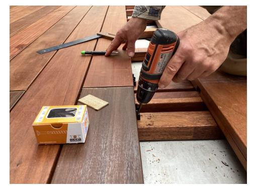
Nachdem die Diele umgedreht wurde, wird sie in den beiden noch sichtbaren Bohrlöchern auf der Unterkonstruktion montiert (Bild: Heco).
