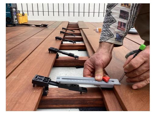
Die Montageposition der Befestigungen aus Kunststoff wird auf den Dielen angezeichnet (Bild: Heco).
