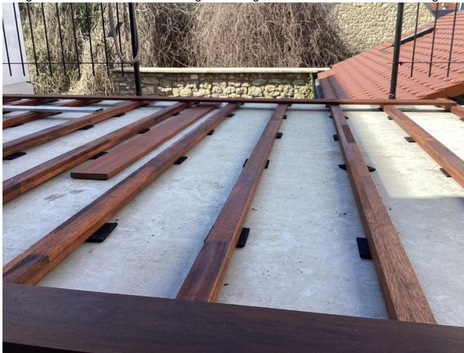
Bei der Verlegung schützt eine Unterkonstruktion die Dielen vor Feuchtigkeit und sorgt für eine Hinterlüftung der Auflageflächen (Bild: Heco).
