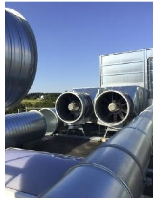
Stützventilatoren für Wärmerückgewinnungssystem (Bild: Höcker Polytechnik).
