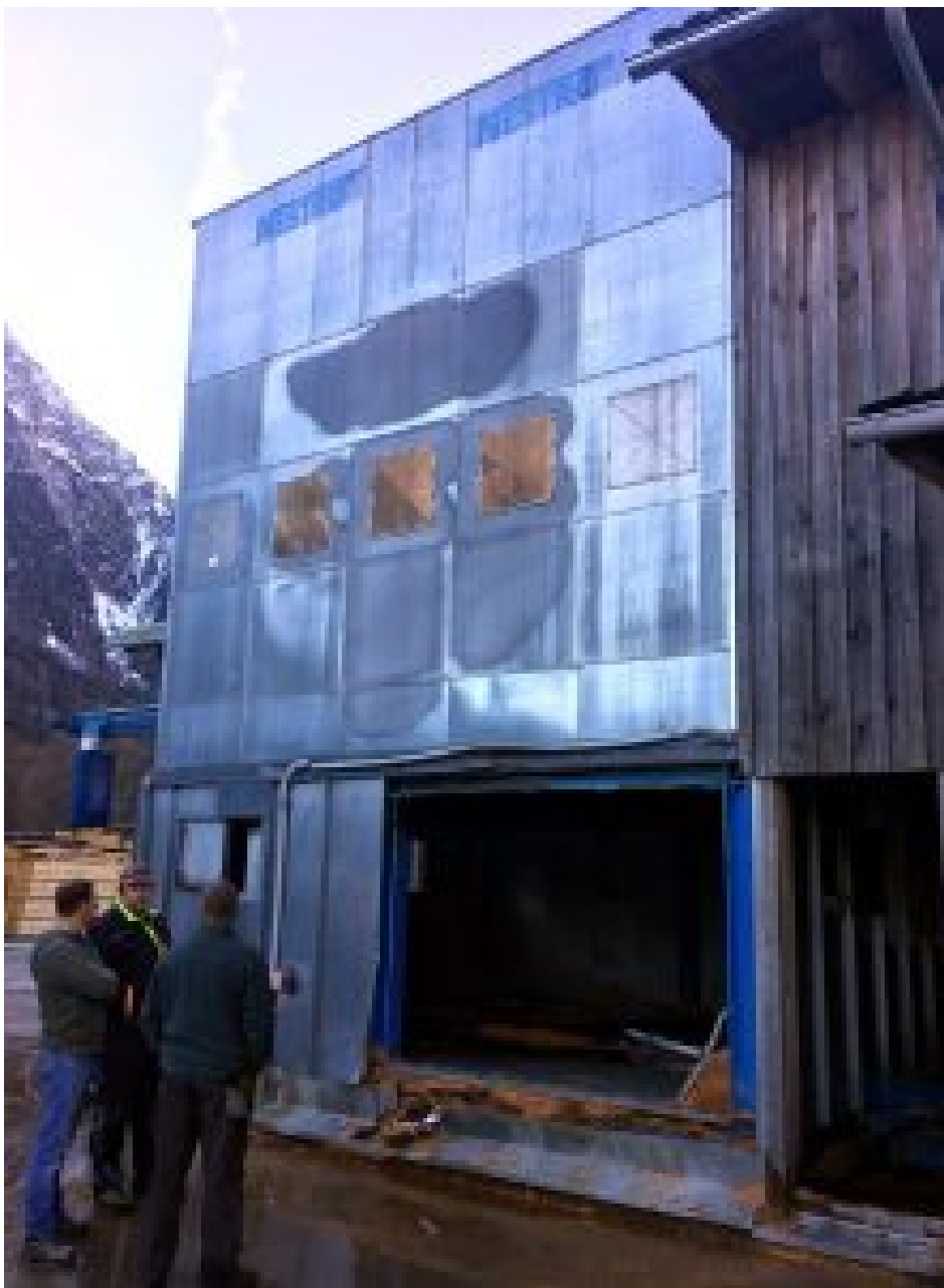
Brandschaden am vorherigen Filter (Bild: Nestro).
