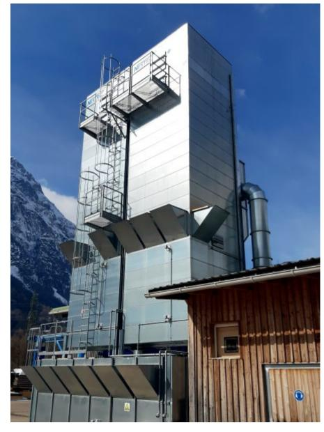
Zwei Unterdruck-Filterhäuser ermöglichen die Filterung großer Luftmengen auf sehr engem Raum (Bild: Nestro).
