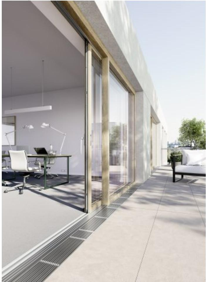
Die niveaugleiche 0-mm-Bodenschwelle erlaubt die Realisierung von Durchgängen nach draußen ohne Hindernis (Bild: Siegenia).
