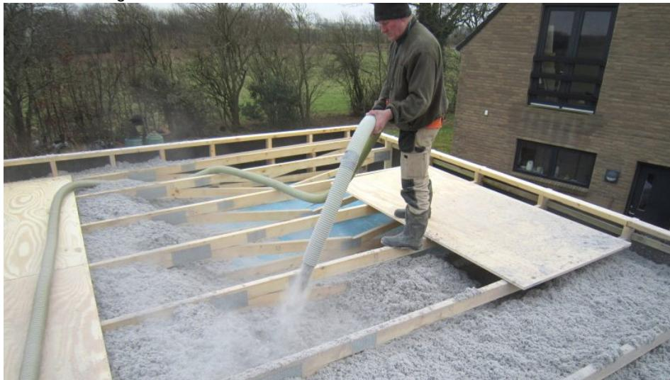
Bei der Energiebilanz von Dämmstoffen schneiden lose Cellulosefasern sehr gut ab
