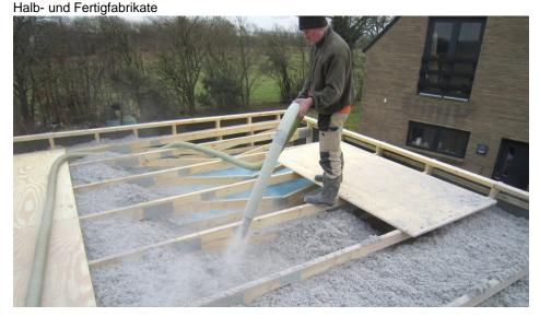
Bei der Energiebilanz von Dämmstoffen schneiden lose Cellulosefasern sehr gut ab (Bild: CWA).
