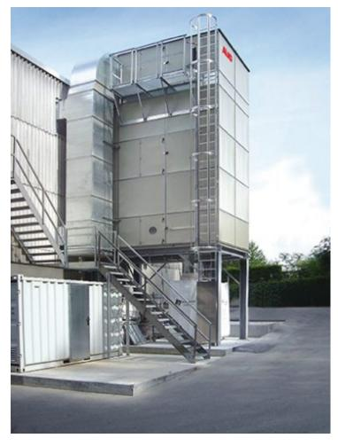
Mit ihrem modularen Aufbau ermöglicht die zentrale Systemfilteranlage den Einsatz für nahezu jede erforderliche Luftmenge (Bild: AL-KO).
