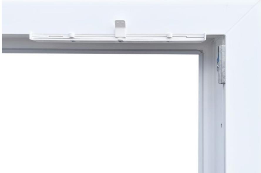
Einbausituation des Fensterfalzlüfters »FFL-m« in einem Fenster (Bild: Regel-air).
