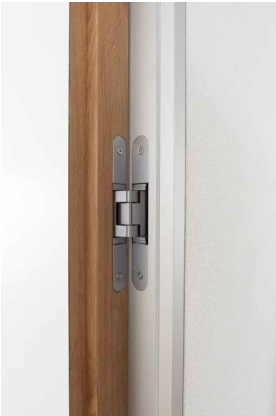
Detailansicht des verdeckten Bandsystems: Türkante Eiche massiv, eloxierte Aluminiumzarge, Wand Filzputz (Bild: Küffner).
