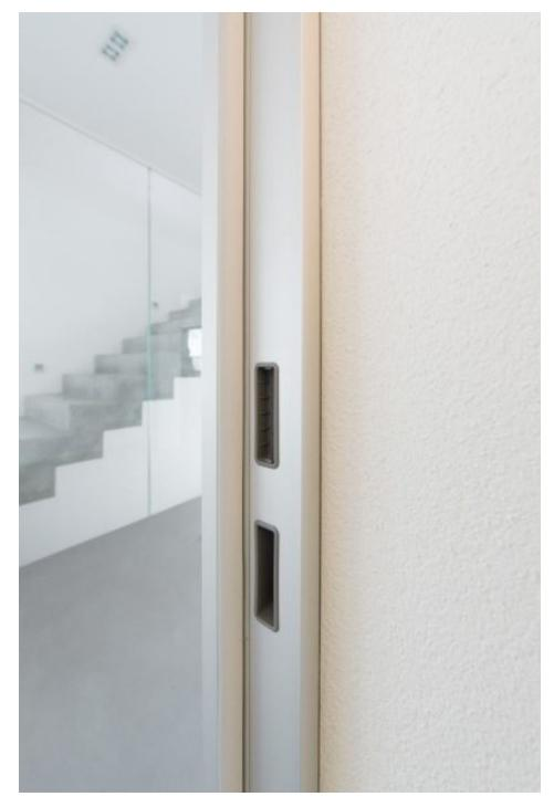
Blockzarge »BZSI«, ausgestattet mit Magnetfallenschloss (Bild: Küffner).
