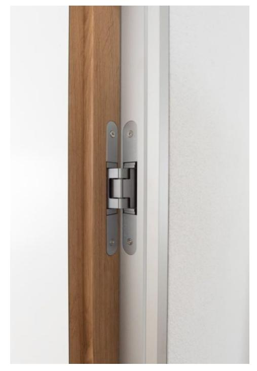
Detailansicht des verdeckten Bandsystems: Türkante Eiche massiv, eloxierte Aluminiumzarge, Wand Filzputz (Bild: Küffner).
