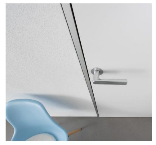
Wandbündig eingebaute Blockzarge (Bild: Küffner).
