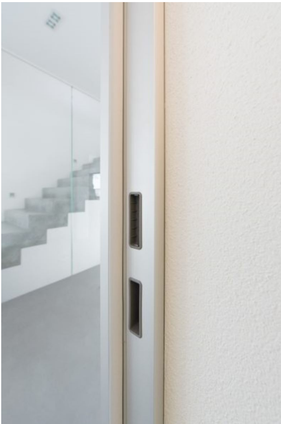
Blockzarge »BZSI«, ausgestattet mit Magnetfallenschloss (Bild: Küffner).
