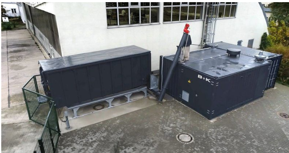
Dezentrale KWK-Anlage »ClinX« (Bild: Prof. Dr. Berg & Kießling GmbH).
