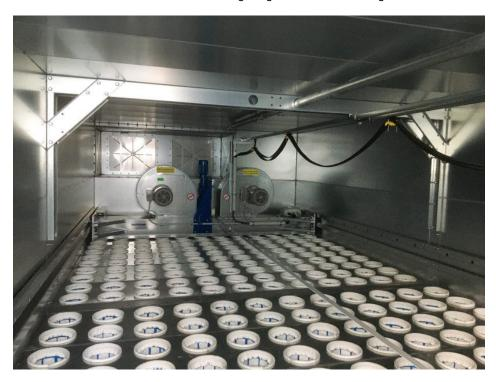
Die kontinuierliche Abreinigung des Filtermaterials mittels Spülluft sorgt für konstant hohe Filterleistung (Bild: Höcker Polytechnik).
