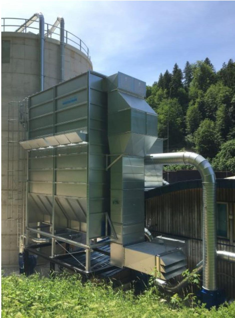
Die neue Filteranlage nutzt das minimale Platzangebot zwischen Silo und Fertigung bestmöglich aus (Bild: Höcker Polytechnik).
