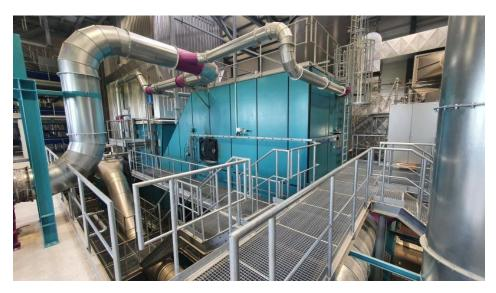
Projektbeispiel für eine 22.000-Kilowatt-Hochdruck-Heißdampfkesselanlage zur Verbrennung von Altholz (Bild: Polytechnik).
