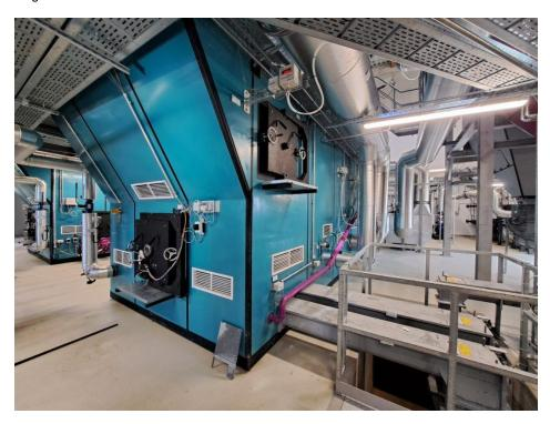
Anlage zur Fernwärmeversorgung in der ungarischen Stadt Kaposvar mit zwei 7500-Kilowatt-Heißwasserkesselanlagen (Bild: Polytechnik).
