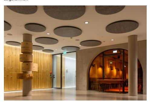
Beispiel für Schallschutz-Deckenelemente (Bild: Sonatech).
