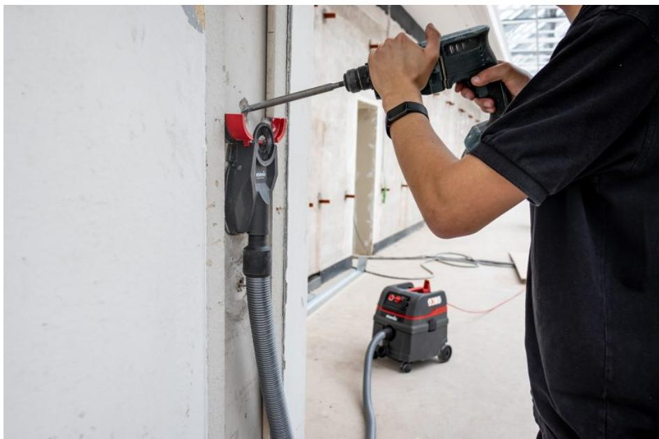
Die Bohrlochabsaugung verfügt über ausklappbare Auffangflügel, die den Absaugbereich vergrößern (Bild: Electrostar).
