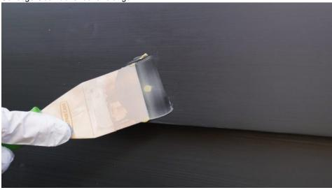
Der 2K-Holz-Feinspachtel ist eine gute Lösung für die schnelle Reparatur kleiner Mängel und Unebenheiten (Bild: Repair Care).
