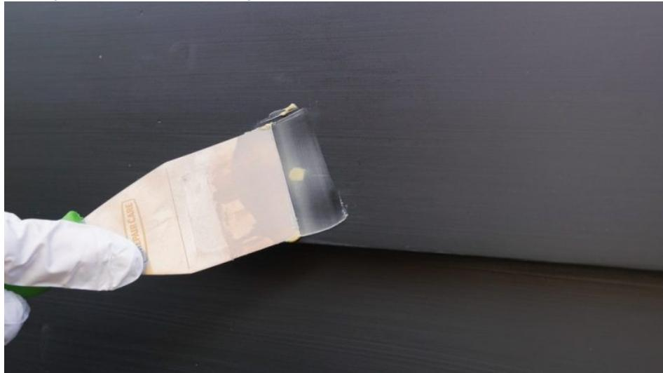
Der 2K-Holz-Feinspachtel ist eine gute Lösung für die schnelle Reparatur kleiner Mängel und Unebenheiten (Bild: Repair Care).
