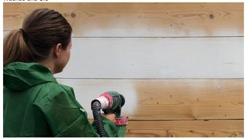
Die Verarbeitung der Aufhellung per Spritzpistole hat den Vorteil von ansatzfreiem Arbeiten an den Kanten und in den Ecken (Bild: Lipfert).
