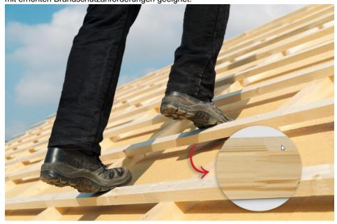
Keilgezinkt bieten die Dachlatten noch mehr Sicherheit (Bild: Egger).
