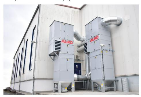
Diese zwei außen aufgestellten Patronenfilteranlagen sorgen z. B. bei einem Metall verarbeitenden Betrieb für saubere Luft in der Produktion (Bild: Al-Ko).
