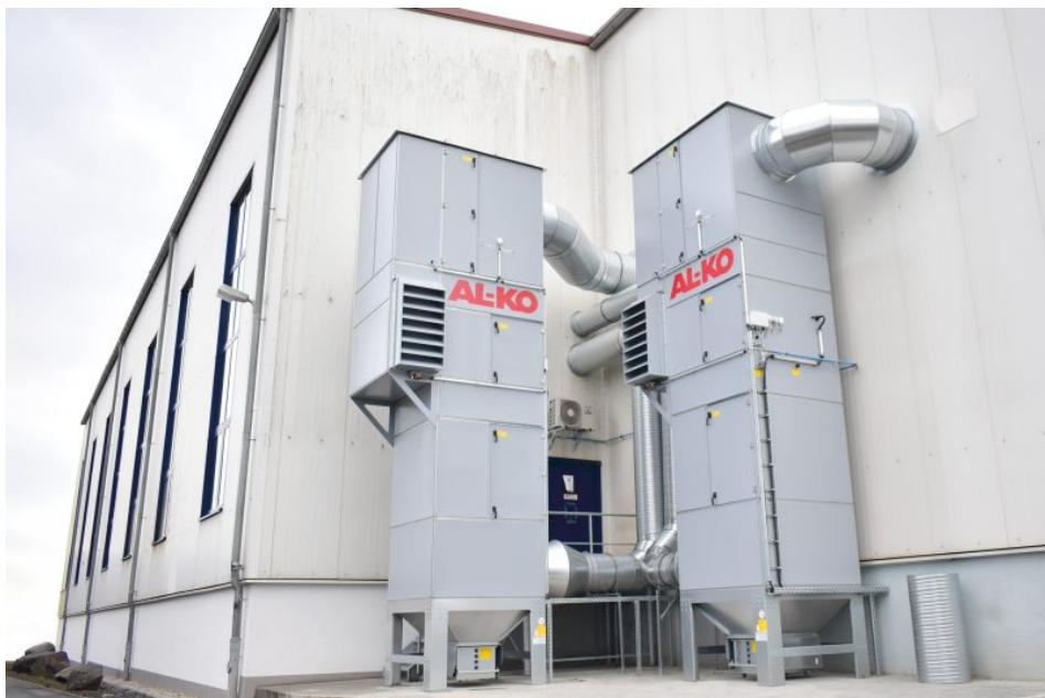
Diese zwei außen aufgestellten Patronenfilteranlagen sorgen z. B. bei einem Metallverarbeitenden Betrieb für saubere Luft in der Produktion (Bild: Al-Ko).
