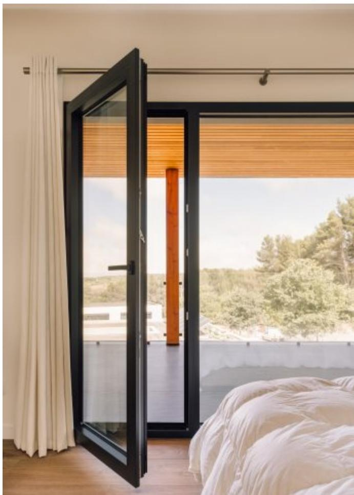
Glasfaser in den Rahmenflügeln erlauben maximale Baugrößen und wie hier bodentiefe
