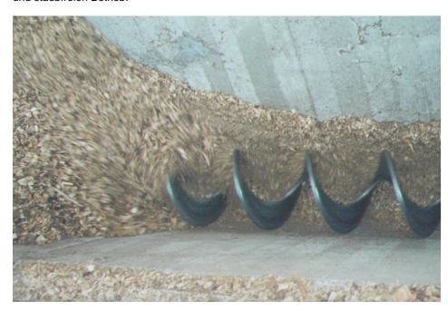
Mit den achsenlosen Förderspiralen erfolgt der Transport der Hackschnitzel effizient und wartungsarm (Bild: Wildfellner).
