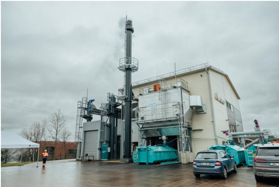
Das schlüsselfertige Projekt für Adven umfasst eine Kesselanlage inklusive Kesselhaus, Brennstofflager und Hackschnitzelzufuhrsystem (Bild: Polytechnik)
