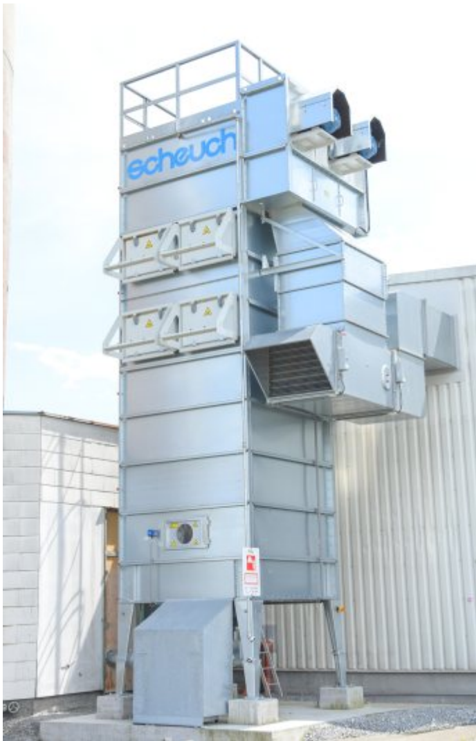
Die bei der Tischlerei Manigatterer installierte Absauganlage arbeitet mit einer Absaugleistung von 33.000 Kubikmetern pro Stunde (Bild: Scheuch Ligno).
