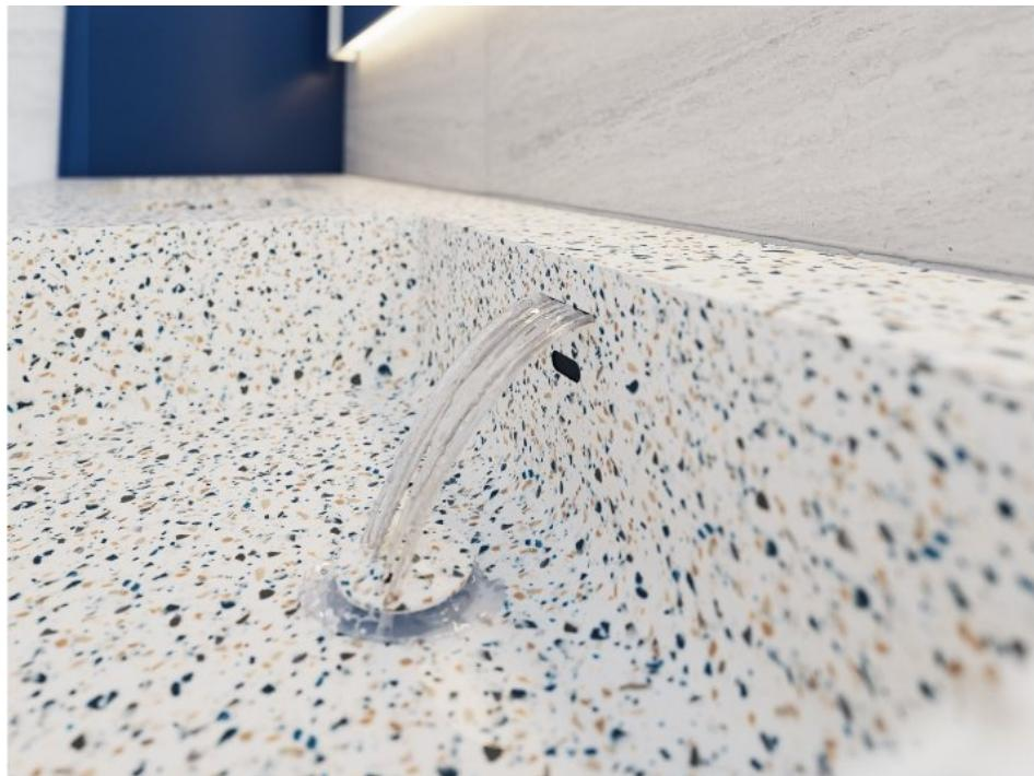
Die Sensorsteuerung gewährleistet einen sparsamen Wasserverbrauch, indem der Wasserfluss nur bei Bedarf aktiviert wird (Bild: Hasenkopf)
