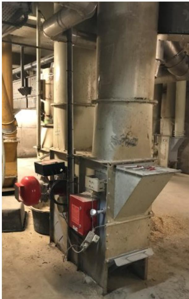
Das Explosionsunterdrückungsmodul erkennt zusammen mit rechteckigem Sensormodul, einen Druckanstieg unmittelbar und stoppt die Explosion (Bild: Bormann & Neupert by BS&B).
