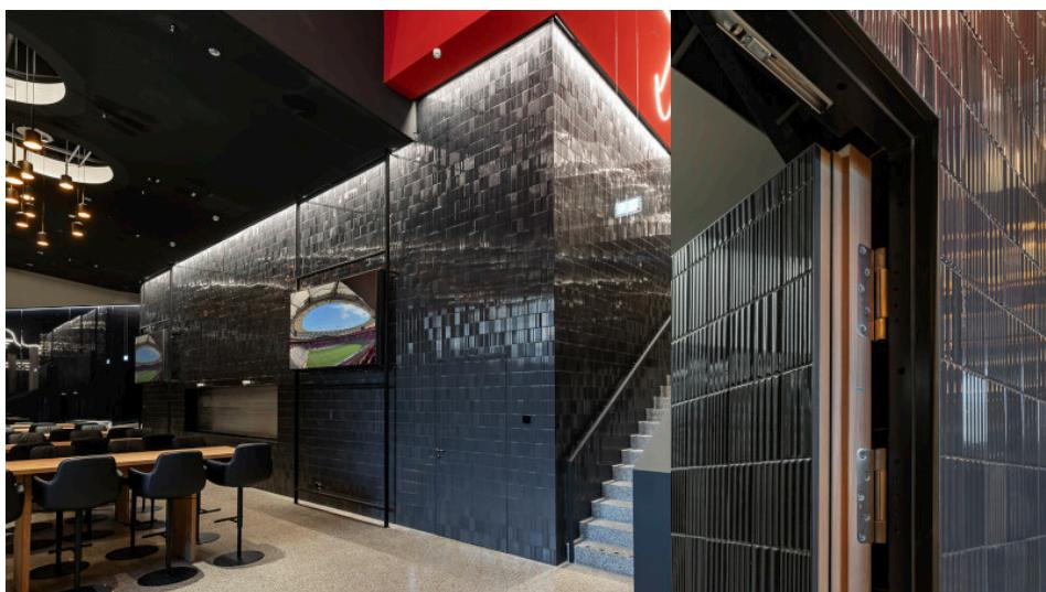
In der MHP Arena wurden auch großformatige Türen mit veredelten Metall- oder Keramikoberflächen verbaut (Bilder: neuformtür).
