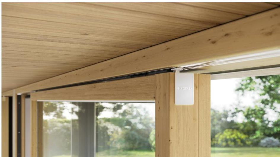
Der motorische Antrieb ist komplett verdeckt liegend integriert (Bild: Siegenia).
