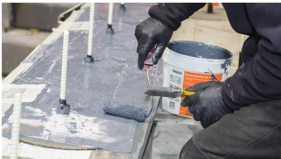
Der weiterentwickelte Flüssigkunststoff lässt sich einfacher verarbeiten (Bild: Bauder).
