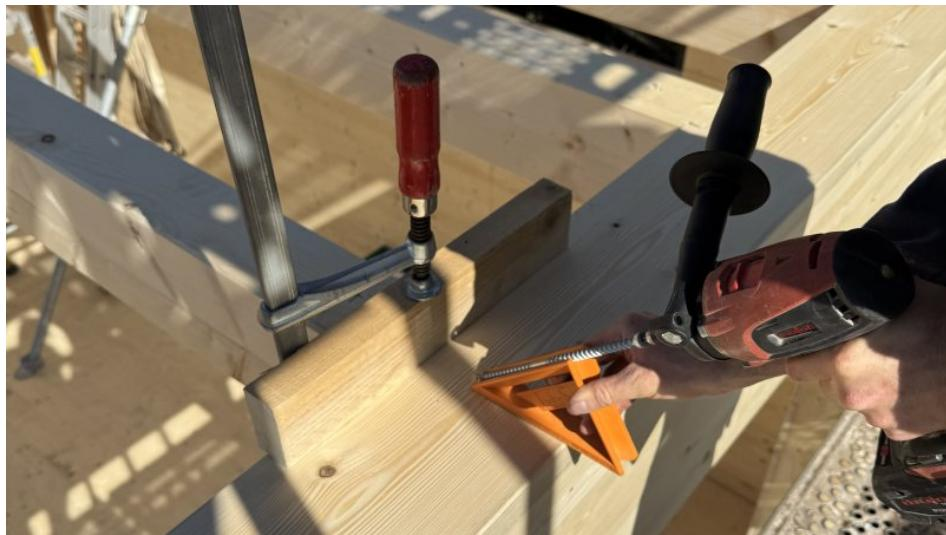
Die Nebenträger wurden über Hilfslatten vorfixiert und anschließend mit den Holzbauschrauben kraftschlüssig verbunden (Bild: Heco).
