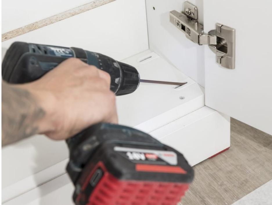
Vor Ort werden die Einzelteile zusammengeschraubt und die Verbinder mit »Cabineo«-Abdeckkappen für einen sauberen Abschluss ergänzt.. Bild: Lamello
