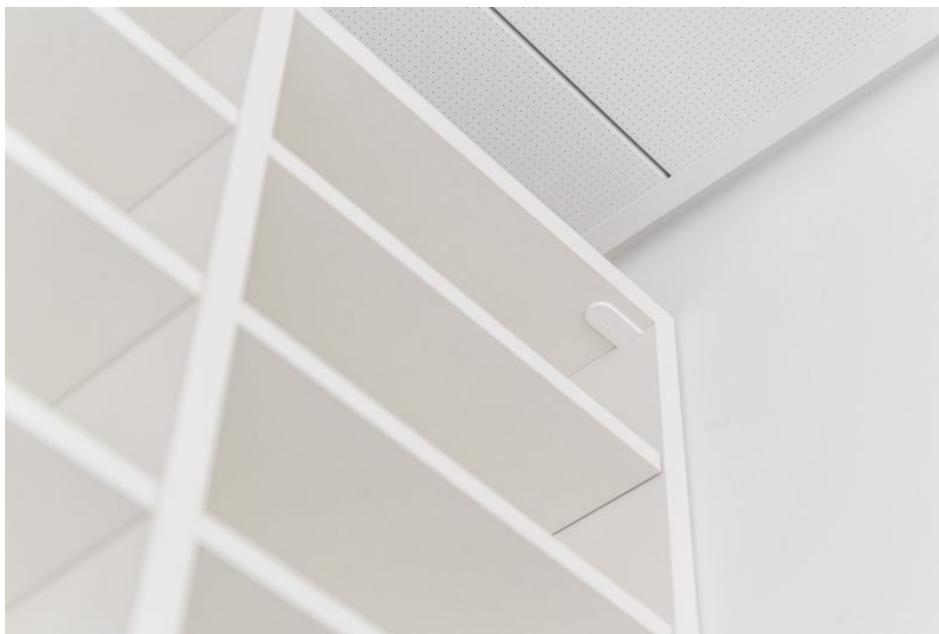
Vor Ort werden die Einzelteile zusammengeschraubt und die Verbinder mit »Cabineo«-Abdeckkappen für einen sauberen Abschluss ergänzt.. Bild: Lamello
