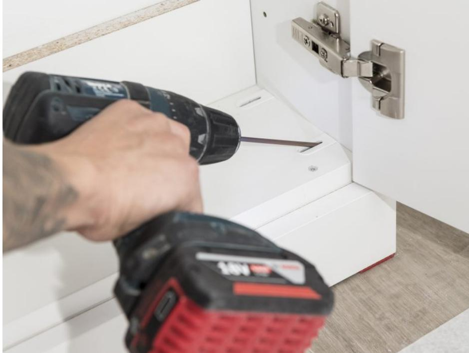
Vor Ort werden die Einzelteile zusammengeschraubt und die Verbinder mit »Cabineo«-Abdeckkappen für einen sauberer Abschluss ergänzt.. Bild: Lamello
