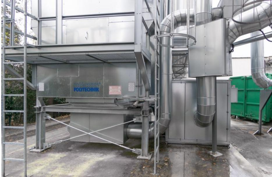
Die Zellenradschleuse (links) und der Transportventilator (rechts) wurden in Schallboxen gekapselt. Bild: Höcker Polytechnik
