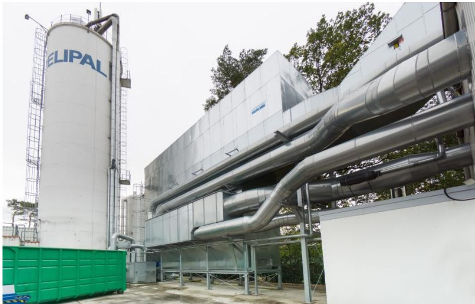
Der »Multistar«-Spülluftfilter bei Pelipal ist mit 35 dB(A) akustisch kaum wahrnehmbar. Bild: Höcker Polytechnik
