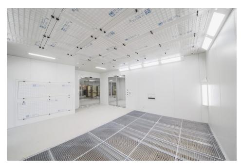
Beim Spritzraum wurde von Scheuch Ligno eine Abluft- und Zuluftanlage eingerichtet, die eine Wärmerückgewinnung von rund 70 Prozent sicherstellt. Bild: Scheuch Ligno
