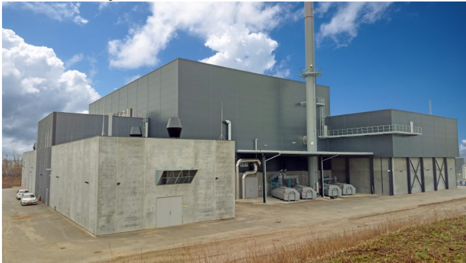
Außenansicht der Heizzentrale Hillerød Forsyning. Bild: Polytechnik
