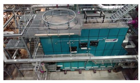
Die Feuerungsanlagen von Polytechnik, jeweils mit adiabater Brennkammer und hydraulisch betätigtem Vorschubrost, bilden das Herzstück der Anlage. Bild: Polytechnik
