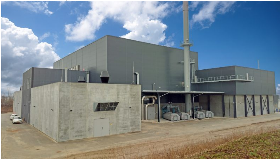
Außenansicht der Heizzentrale Hillerød Forsyning. Bild: Polytechnik
