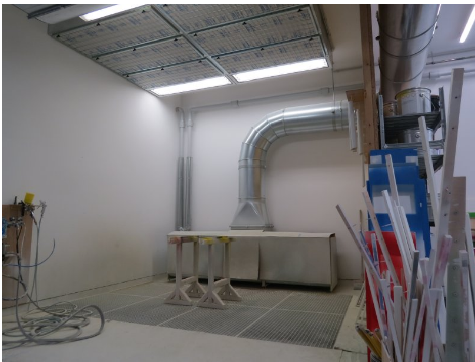
Die Farbnebelerfassung erfolgt über ein Oberflurfiltermodul in Trockenabscheidung. Bild: Nestro
