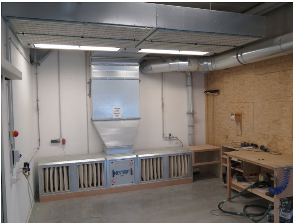
Der Schleifstand »NST 75« sorgt für weiträumige Staubfreiheit im Schleifbereich. Bild: Nestro
