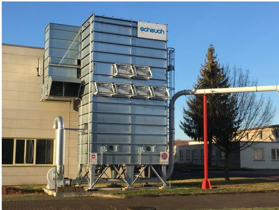
Der besonders effiziente Impulsfilter mit Druckluftabreinigung sorgt für höchstmögliche Energieeffizienz. Bild: Scheuch Ligno
