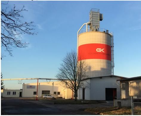
Die Späne werden mit einer Leistung von 2,5 Tonnen pro Stunde über eine Entfernung von knapp 100 Metern zu einem Abscheidefilter auf dem Spänesilo befördert. Bild: Scheuch Ligno
