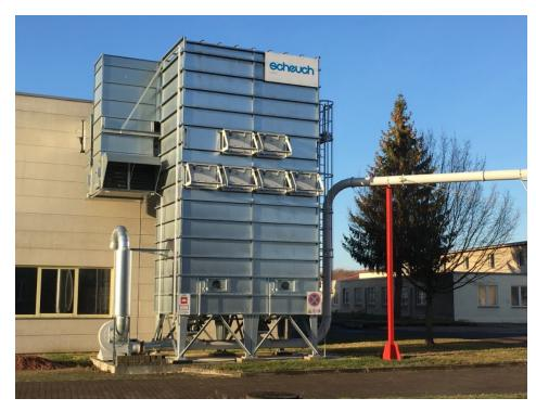
Der besonders effiziente Impulsfilter mit Druckluftabreinigung sorgt für höchstmögliche Energieeffizienz. Bild: Scheuch Ligno
