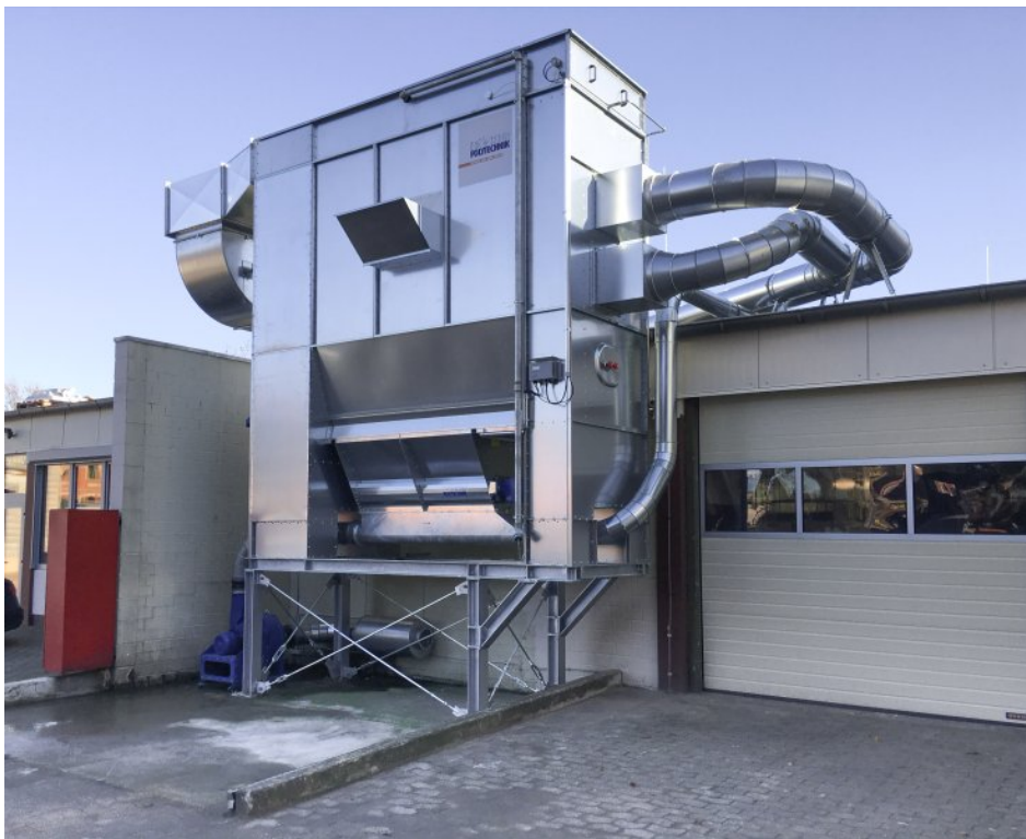
Der neue »Multistar C«-Kompaktfilter mit integrierter Zellenradschleuse und
