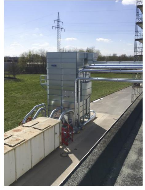
Die Filteranlage benötigt lediglich 16 Quadratmeter Stellfläche (Bild: Höcker Polytechnik).
