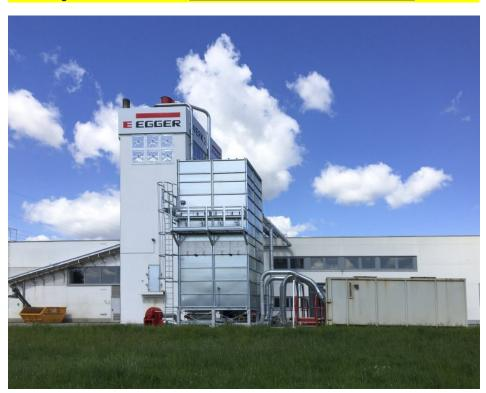
Die neue Filteranlage mit Silo und Containerstation. Für das automatisierte
