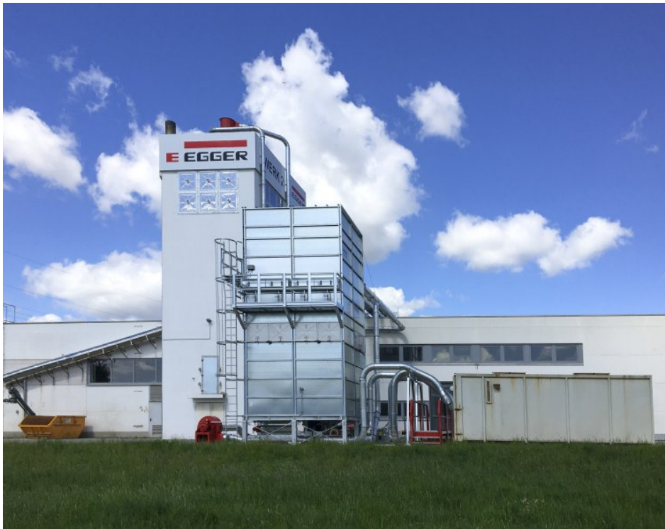
Die neue Filteranlage mit Silo und Containerstation. Für das automatisierte
