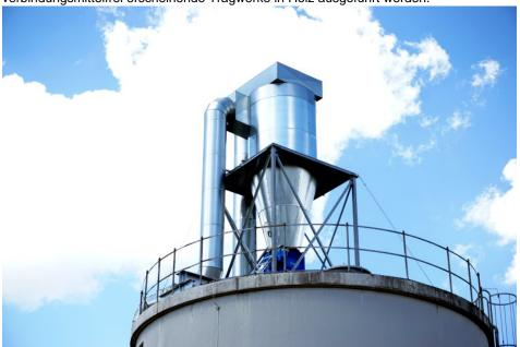
Der Zyklon ist komplett schallisoliert – eine der Schallschutzmaßnahmen, um den vom Ordnungsamt Rosenheim geforderten maximal zulässigen Immissionsrichtwert von 54 dB(A) sicher einzuhalten (Bild: Nestro).
