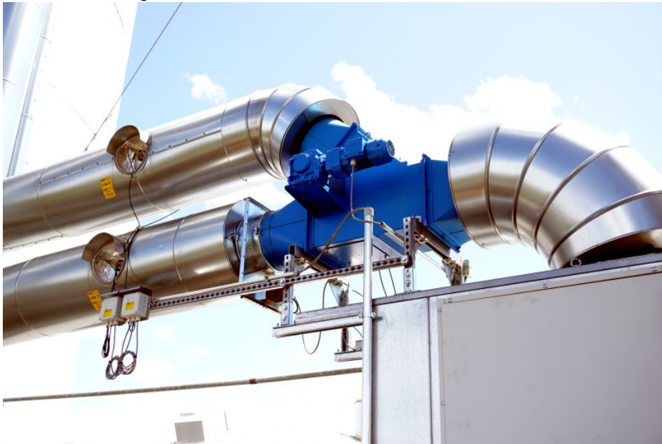
Automatische Druckrohrweiche und Containerstation (Bild: Nestro).
