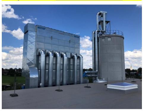
Die abgesaugte Rohluft wird zum Filter geleitet, Staub und Späne werden abgeschieden und druckfrei in den Spänesilo abgegeben (Bild: Nestro).
