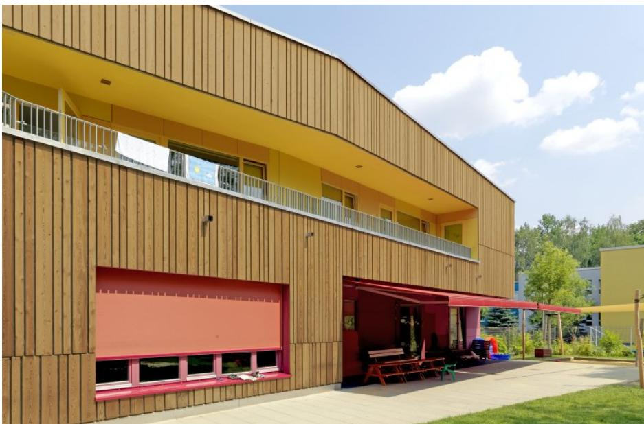
Die lösemittelbasierte Holzfarbe schützt vor äußeren Witterungseinflüssen und bewahrt Verbretterungen, Fassaden oder Zäune vor Pilzbefall (Bild: Brillux).
