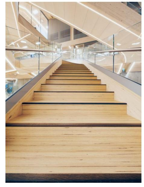
Strapazierfähig und rutschhemmend: Die Stufen und Setzstufen der Massivholztreppe wurden mit dem »HWS-112«-Hartwachs-Siegel versehen (Bild: Remmers).
