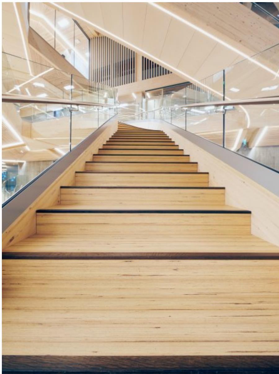
Strapazierfähig und rutschhemmend: Die Stufen und Setzstufen der Massivholztreppe wurden mit dem »HWS-112«-Hartwachs-Siegel versehen (Bild: Remmers).
