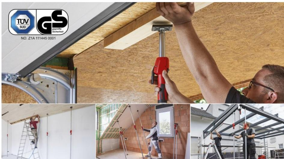
Die neue Decken- und Montagestütze ermöglicht Fixierarbeiten in bis zu 3,70 m Höhe und ist einfach zu bedienen (Bild: Bessey).
