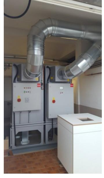
Für die Absauganlage werden serienmäßig energiesparende Motoren der Effizienzklasse IE3 eingesetzt. (Bild: Spänex).
