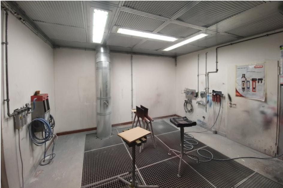
Blick in den Lackierraum mit der neuen Unterflurabsaugung (Bild: Spänex).
