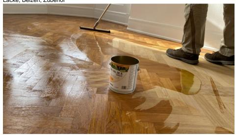
Mithilfe eines Applikators konnte die Öl-Wachs-Kombination in rückenschonender Haltung aufgetragen werden (Bild: Pallmann).
