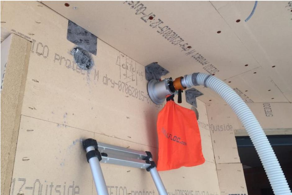
Einbringen des Cellulose-Dämmstoffs in die Hohlräume per Einblasmachine (Bild: CWA).
