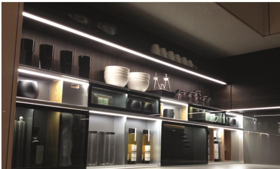
Ein Beispiel für eine aktuelle Beleuchtungslösung ist die Verwendung von Linienleuchten für Lichtbänder ohne Dunkelzonen (Bild: Hera).
