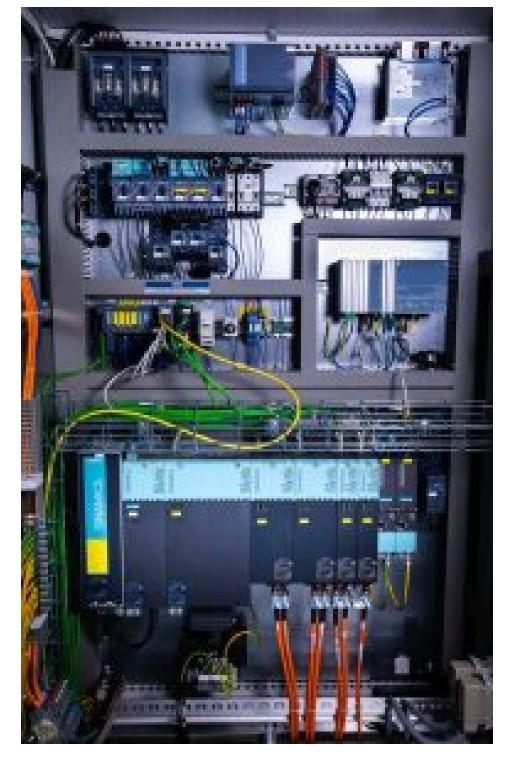
Die flexible Kombination von »Sinamics S210«- und »S120«-Antrieben sowie »Simotics 1FK2«- und »1FK7«-Motoren an der »Sinumerik MC«-Steuerung ermöglicht passgenaue Maschinenlösungen (Bild: Siemens).
