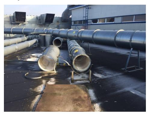
Typische Ablagerungen innerhalb einer Transportleitung (Bild: T&B electronic).
