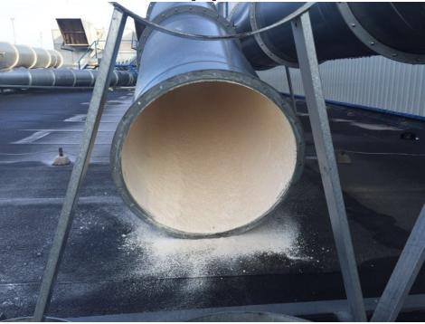
Es ist zu erkennen, dass sich die Ablagerungen nicht nur im unteren Bereich, sondern überall an der Wandung befinden (Bild: T&B electronic).
