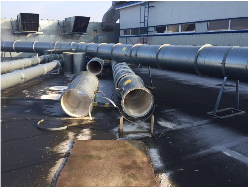
Typische Ablagerungen innerhalb einer Transportleitung (Bild: T&B electronic).
