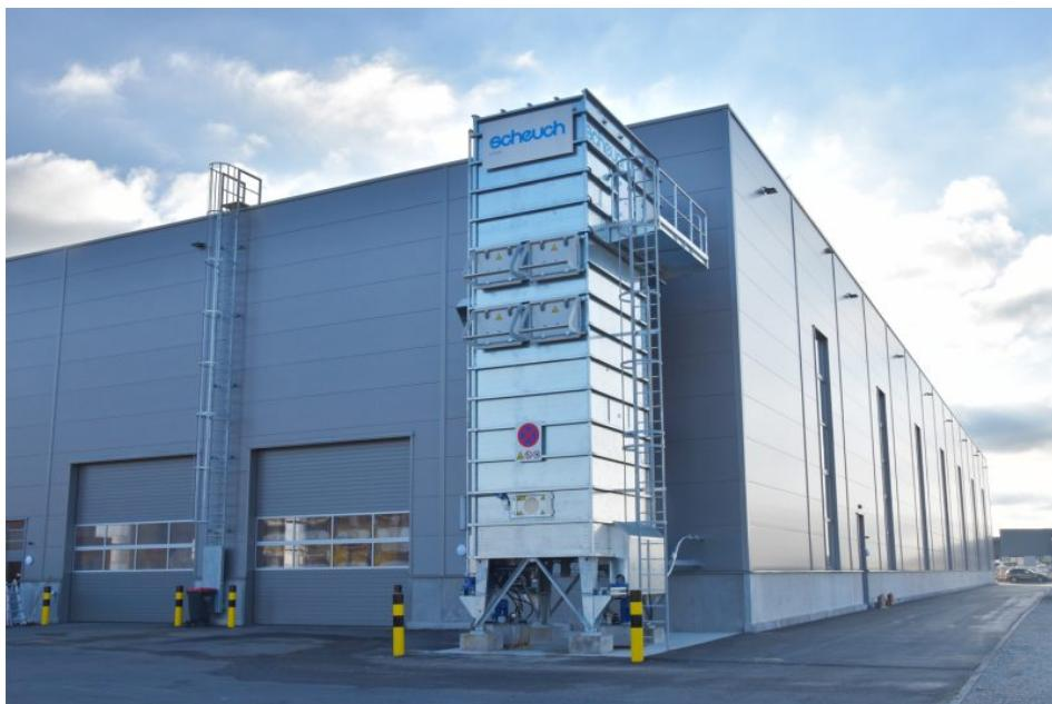
Die neue Absauganlage bei der Leidorf GmbH hat eine Leistung von 40.000 m<sup>3</sup>/h (Bild: Scheuch Ligno).
