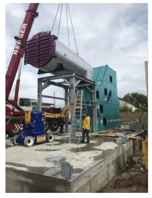
Montage des Wärmetauschers auf einem Stützgerüst neben der Mittelstromfeuerung auf der zuvor erbauten Bodenplatte (Bild: Furnierwerk Bühl).
