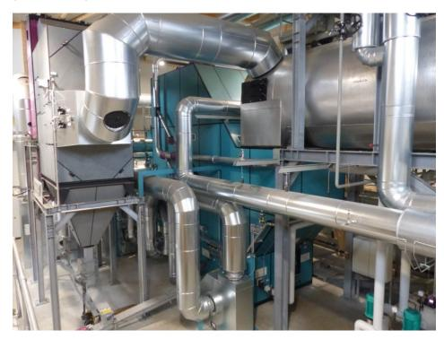
Die 4,9-Megawatt-Feuerungsanlage liefert permanent die benötigte Wärme für das Furnierwerk (Bild: Polytechnik).
