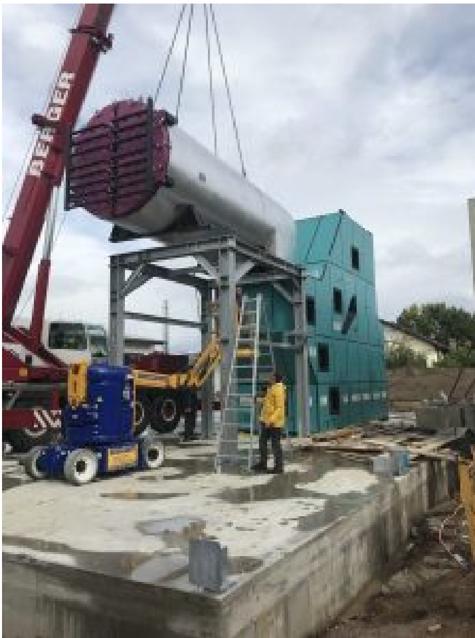
Montage des Wärmetauschers auf einem Stützgerüst neben der Mittelstromfeuerung auf der zuvor erbauten Bodenplatte (Bild: Furnierwerk Bühl).
