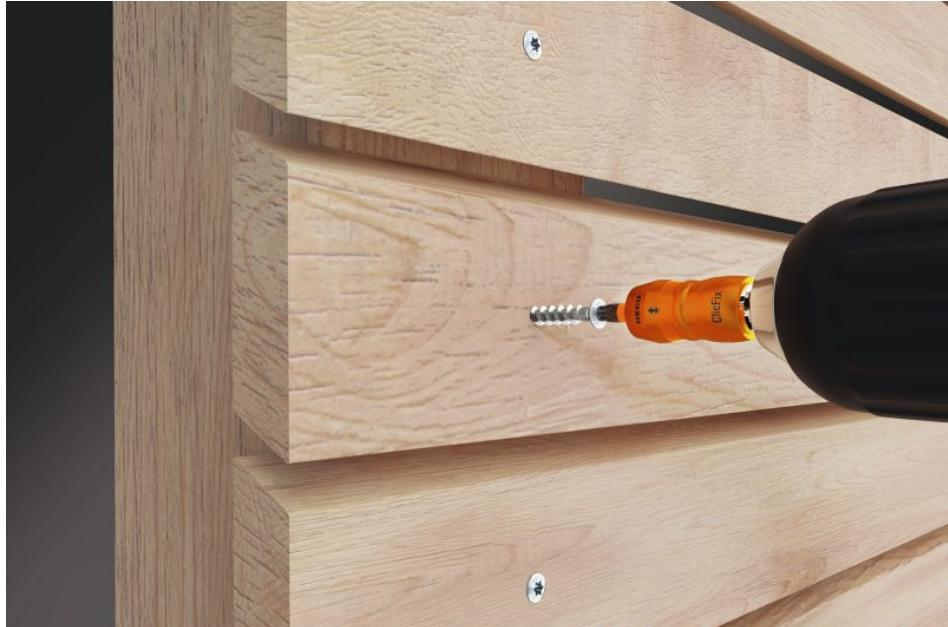
Die Schraube lässt sich selbst in Edelstahl einhändig auf dem Holz ansetzen und verarbeiten (Bild: Heco).
