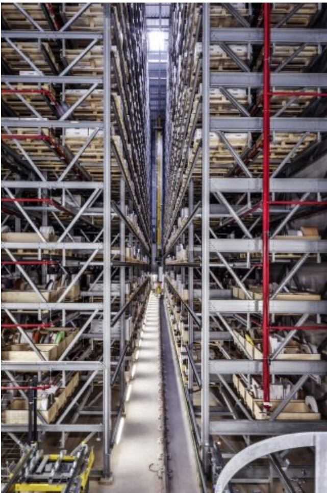
Hochregallager im neuen Logistikzentrum (Bild: Rehau).
